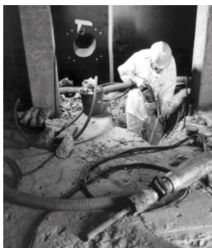
Sloper aan het werk
